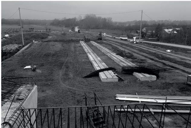
Roboty nad zjazdem do drogi w kierunku Solca n. Wisłą, której... nie ma (fot. Ewelina Kaźmierak)
