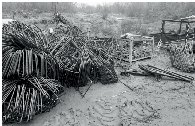
Pręty, zbrojenia, tążenia i mnóstwo innych, które razem ważą ~11 tys. ton! (fot. Ewelina Kaźmierak)
