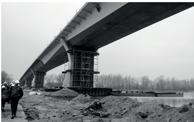
Najwyższy z filarów, na którym będzie oparta konstrukcja ~18,5 m n.p.t. (fot. Ewelina Kaźmierak)
