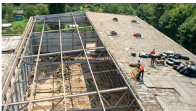
Hala sportowa w trakcie rozbiórki (fot. S. Szewczuk)
