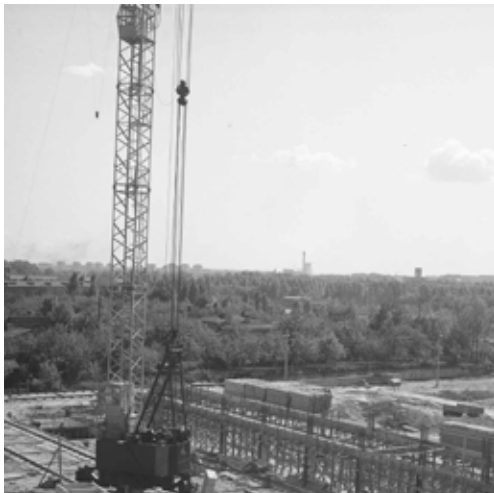
Wydział Mechaniczny w budowie
