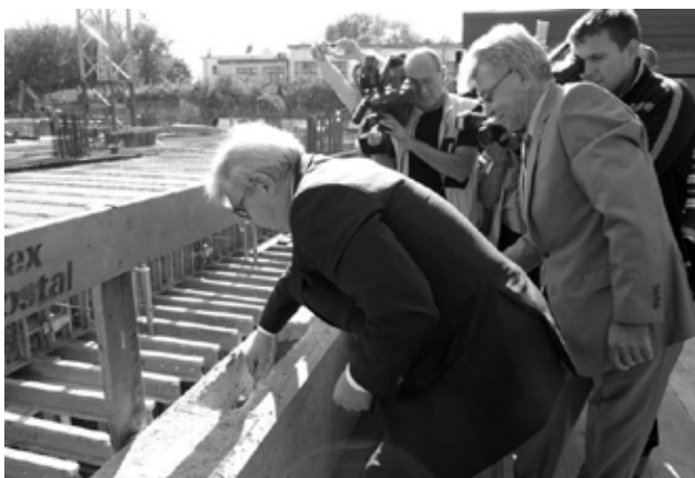
Wmurowanie aktu erekcyjnego pod budowę Centrum Innowacji i Zaawansowanych Technologii przez Rektora prof. Marka Opielaka
