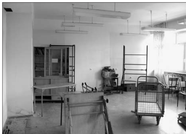
Piętro III – przygotowania do prac remontowych
