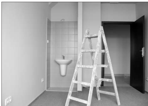
Piętro IV – ostatnie prace wykończeniowe
