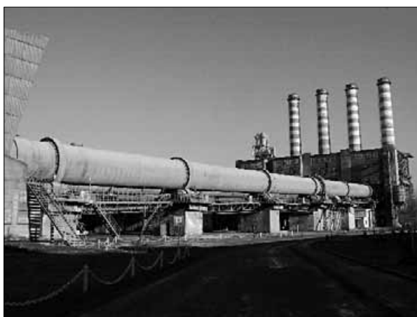
Piece obrotowe w cementowni Chełm II
