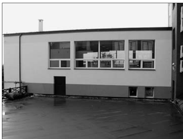
Widok budynków nowego skrzydła Wydziału Inżynierii Środowiska
