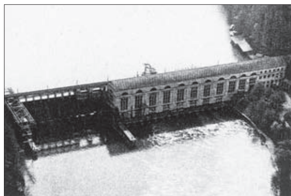
Stare zdjęcie lotnicze elektrowni Mühleberg na rzece Aare w pobliżu Berna. zdj. BKW, Berno
