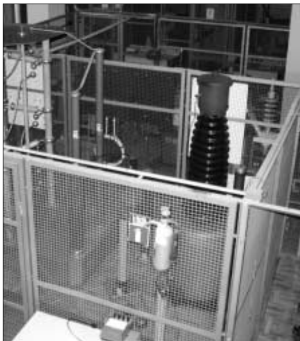
Laboratorium techniki wysokich napięć
