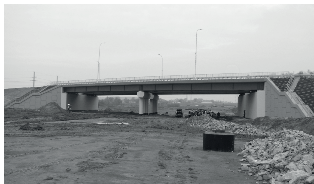
Prace końcowe budowy wiaduktu
