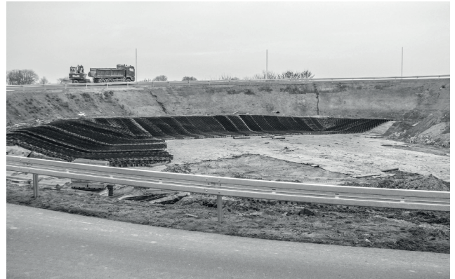
Prace przy umocnieniu skarp
