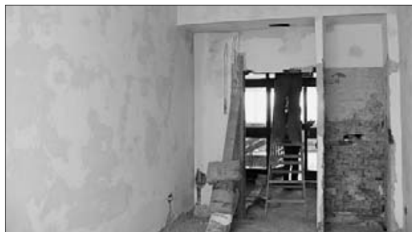
Remont V piętra Wydziału Inżynierii Budowlanej i Sanitarnej
