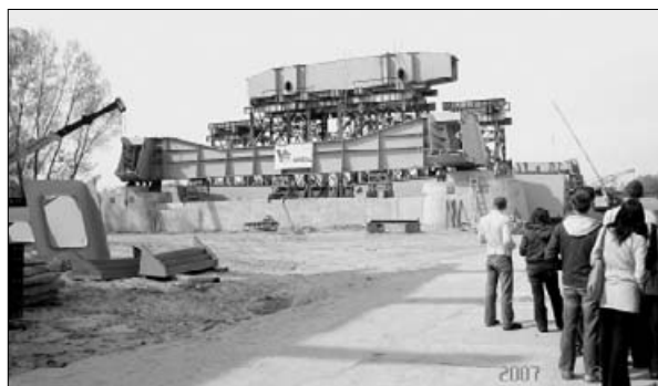
Obwodnica Puław – fundamenty filarów nurtowych w dn. 16.10.2006 r. oraz węzeł podporowy łuku w dn. 23.04.2007 r.
