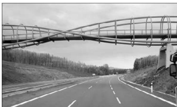
Nowe odcinki A17 i D8
